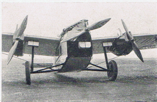
Fig. 13. Train d'atterrissage
