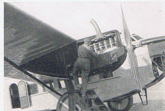
Fig. 17. Moteur latéral d'avion
